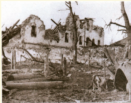
Разрушенное здание. Холм
